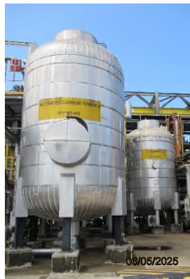
ภาพถ่ายที่ 2.2.1-8 หอด้านกัมมันต์สำหรับดูดซับซัลเฟอร์
