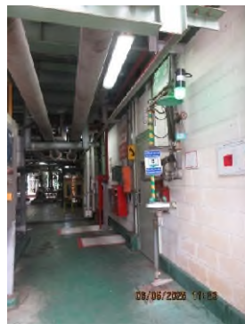
ภาพถ่ายที่ 2.2.1-35 ฝักบัวและที่ล้างตาฉุกเฉิน ในพื้นที่ที่เกี่ยวข้องกับสารเคมี
