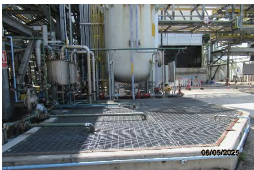
ภาพถ่ายที่ 2.2.1-15 บ่อรวบรวมน้ำเสีย (Wastewater Sump) ของส่วนผลิต CO
