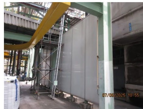
ภาพถ่ายที่ 2.2.1-23 ถังเก็บสารดูดซับ กรณีสฟิงเจอร์เหลวรั่วไหล
