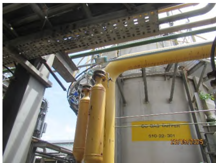
ภาพถ่ายที่ 2.2.1-40 ระบบ Gas Buffer
