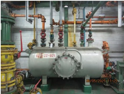
ภาพถ่ายที่ 2.2.1-1 ระบบกำจัดก๊าซฟอสจีน (Phosgene Decomposition System)
