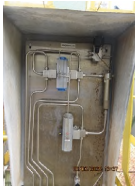
ภาพถ่ายที่ 2.2.1-11 อุปกรณ์ตรวจวัดอัตโนมัติ Phenolic Online
