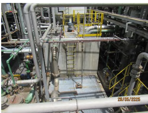
ภาพถ่ายที่ 2.2.1-15 บ่อรวบรวมน้ำเสีย (Wastewater Sump) ของส่วนผลิต CO
