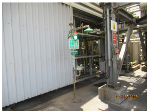
ภาพถ่ายที่ 2.2.1-37 ฝักบัวฉุกเฉินและอ่างล้างตาฉุกเฉิน ส่วนผลิต CO
