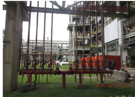
ภาพถ่ายที่ 2.2.1-43 อุปกรณ์วัดความดัน
