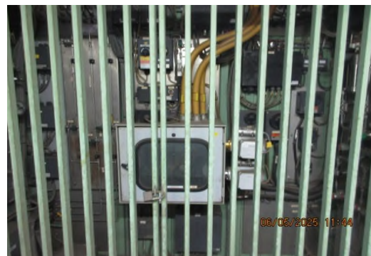
ภาพถ่ายที่ 2.2.1-54 เครื่องตรวจวัดฟอสจีน
