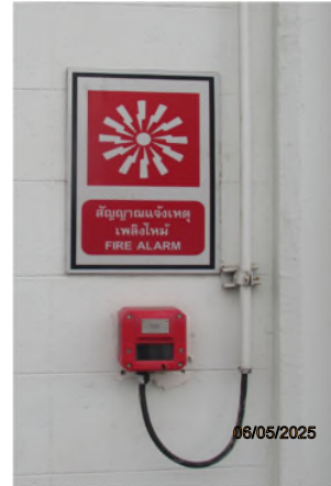
ภาพถ่ายที่ 2.2.1-52 ปุ่มแจ้งสัญญาณไฟไหม้ (Fire Alarm Button) ในส่วนผลิต CO
