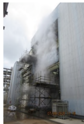
ภาพถ่ายที่ 2.2.1-55 การทดสอบผ่านน้ำยา Steam-Ammonia
